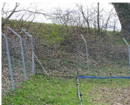
Figura 2 Recinzione esterna interrata e interna con doppio filo elettrico
